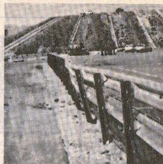
Due esempi di guardrails proposti dall'Acai, l'associazione costruttori in acciaio italiani. Sopra: le barriere di nuova generazione che si deformano senza pericolosi distacchi di elementi. A sinistra: barriera in acciaio alta 120 centimetri con 2 elementi longitudinali e nastro pararuote.
