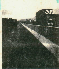
1-2 - Durante i lavori per la terza corsia per il tratto da Caserta a Napoli dell'autostrada Roma-Napoli, i cantieri sono stati protetti dal traffico autostradale attraverso barriere prefabbricate in calcestruzzo del tipo New Jersey. Le barriere vengono poi spostate in centro della sezione autostradale per costituire la barriera permanente spartitraffico, che come è noto protegge efficacemente contro gli scavalcamenti, anche di veicoli pesanti.
